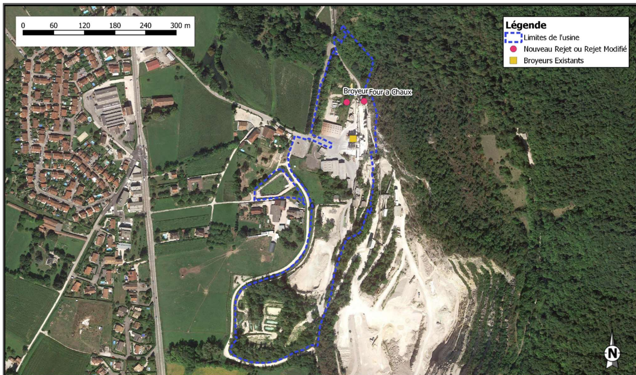
Figure 2 : Localisation des rejets canalisés
